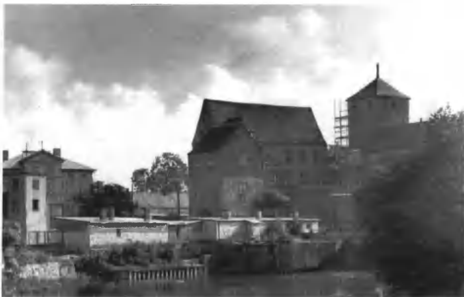
7. Widok na zamek w trakcie remontu, na pierwszym planie prowizoryczne baraki, w których na czas remontu umieszczono pracowników i część księgozbioru, 10 IX 1979 r.; fot. Z. Lewicki
