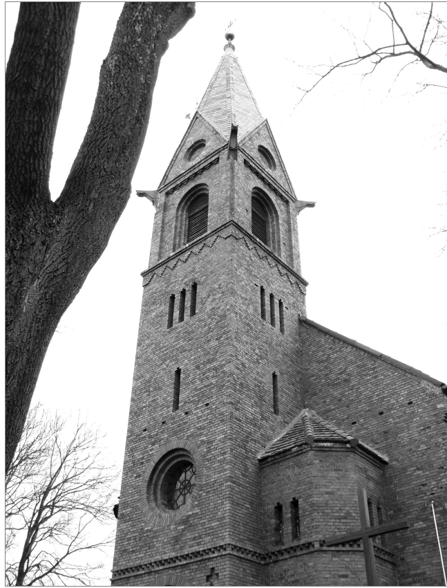
Ryc. 8. Kowalewice. Wieża kościoła. Fot. K. Kontowski, 2006 r.
