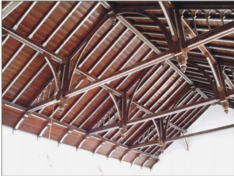
A. Jeżyce, drewniany strop kościoła nad nawą główną. Fot. K. Kontowski, 2006
