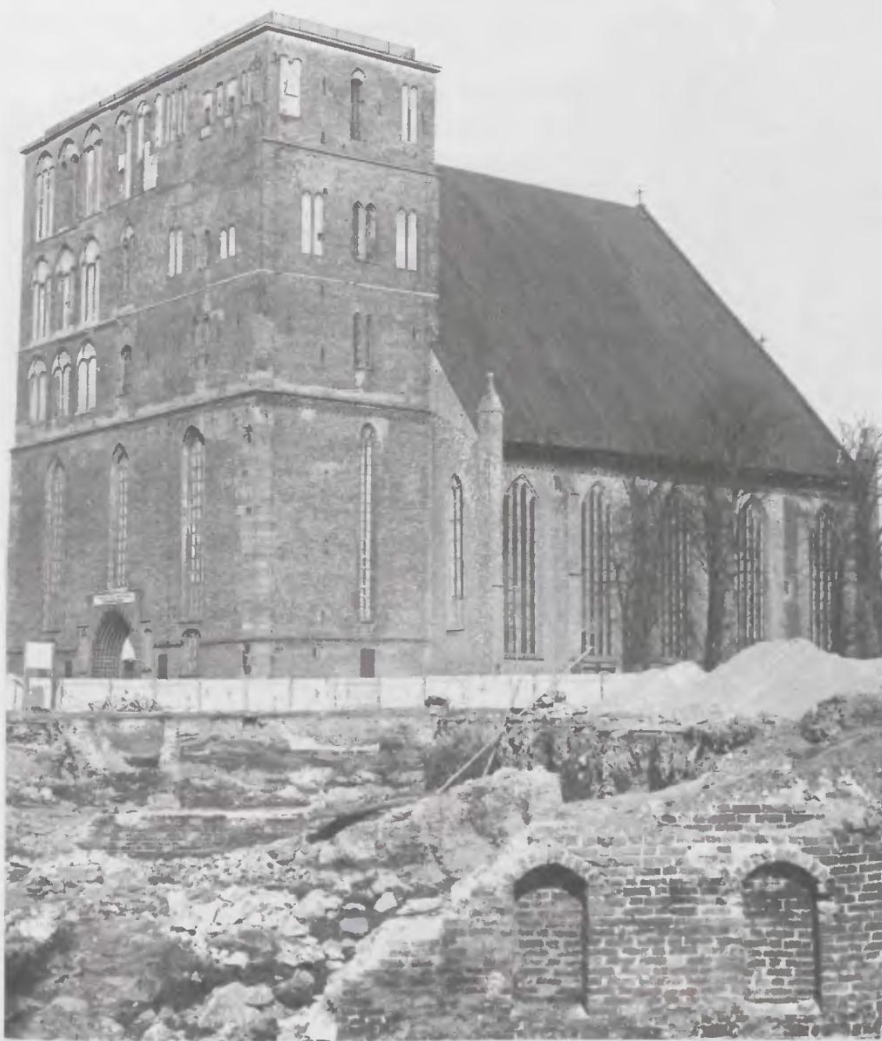
Fot. 3. Kwartał sąsiadujący bezpośrednio z Bazyliką p.w. Wniebowzięcia NMP, w którym na początku 1984 roku rozpoczęto prace budowlane bez uzgodnienia z WKZ. Na pierwszym planie gotyckie mury pomiędzy ulicami Katedralną i Mariacką, odsłonięte podczas wstrzymanych decyzją WKZ w Koszalinie z 28.02.1984 roku. Od tego miejsca i od tej chwili rozpoczęła się historia nowej „Starówki” w Kołobrzegu. Fot. F.J. Lachowicz
