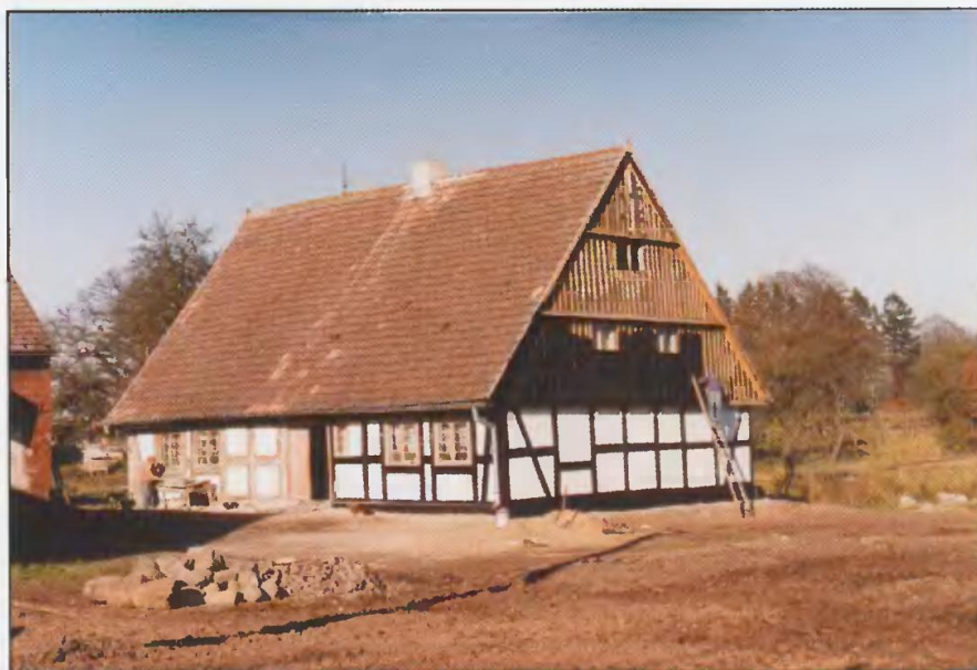
A. Bruszkowo Wielkie. Chałupa z połowy XIX wieku. Prace remontowo- renowacyjne w 1998 roku. Fot. E. Szalewska.
