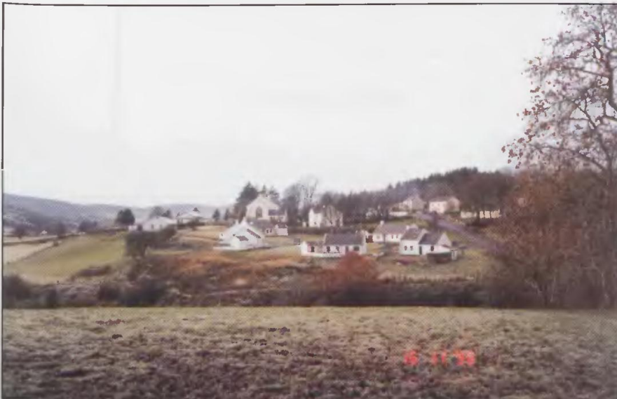
B. Cranagh, Irlandia Północna. Nowa zabudowa mieszkaniowa wkomponowana jest w sylwetę starej wsi. Fot. E. Raszeja.
