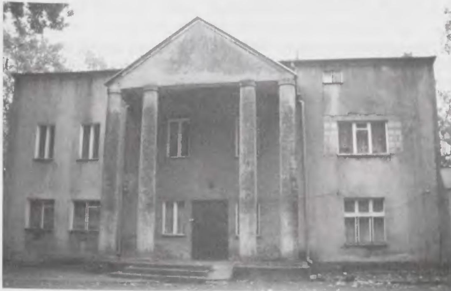
Fot. 4. Komorniki k. Poznania. Przykład pałacu neoklasycystycznego z drugiej połowy XIX wieku, którego architektura została dramatycznie zniszczona przez współczesną przebudowę. Pozostaje retoryczne pytanie: Kto wydał na to zgodę? Fot. W. Rączkowski
