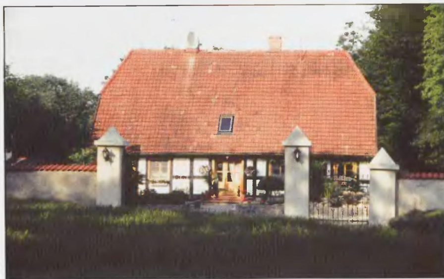
B. Stary Kraków, gm. Sławno. Przykład domu w konstrukcji szachulcowej wyremontowanego i zaadaptowanego do współczesnych potrzeb. Fot. W. Rączkowski.
